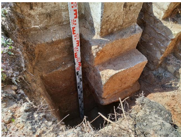
Abbildung 35: Fundamenterkundung Schurf 3/25
