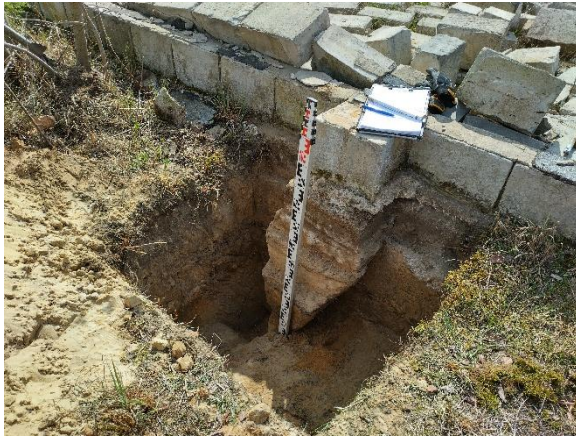
Abbildung 31: Fundamenterkundung Schurf 1/25
