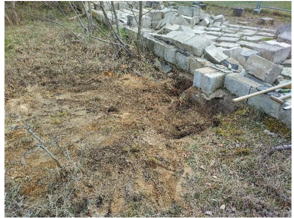
Abbildung 32: Fundamenterkundung Schurf 1/25
