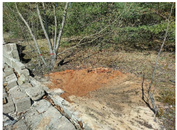
Abbildung 36: Fundamenterkundung Schurf 3/25
