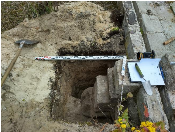
Abbildung 33: Fundamenterkundung Schurf 2/25
