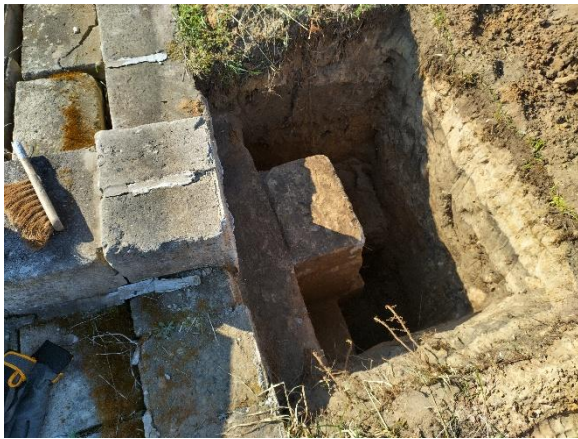
Abbildung 39: Fundamenterkundung Schurf 5/25
