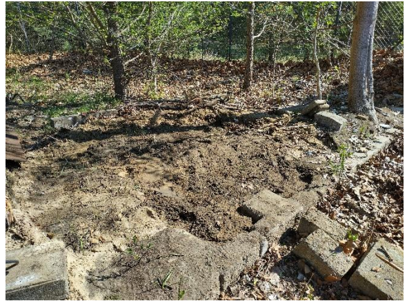
Abbildung 38: Fundamenterkundung Schurf 4/25
